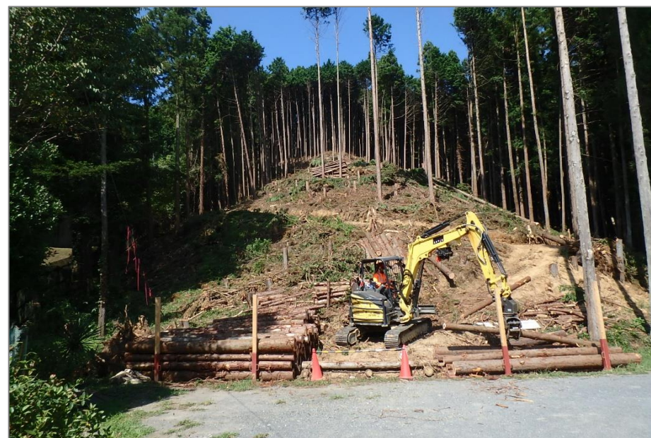
② 対象地(全景・伐採中) 2020年8月撮影
