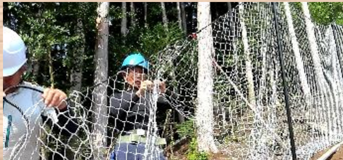
獣害防護柵を設置しているところ
