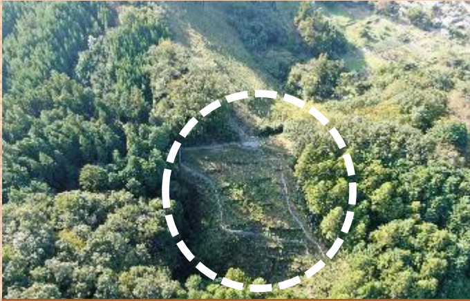
防護柵を設置した山の一部分
